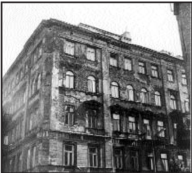
Al. Jerozolimskie 63 - stan po skuciu wystroju w 1973 roku
